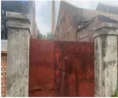
厂区东侧广源废矿物油回收公司
