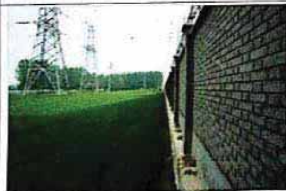
变电站北墙外
