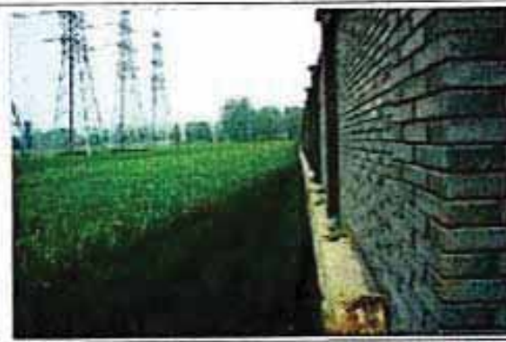
变电站南墙外
