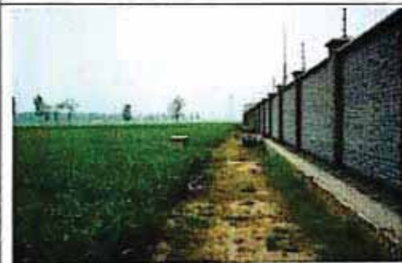
变电站东墙外（衰减断面）
