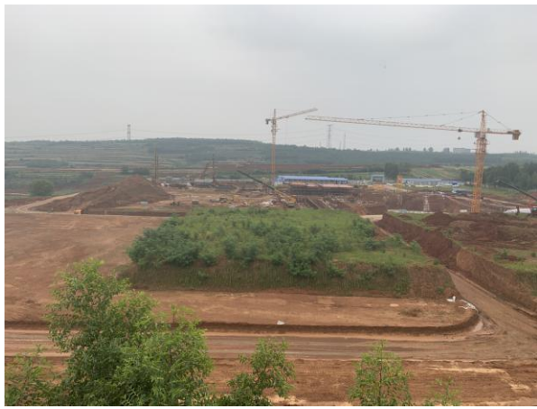
垃圾电厂现状照片
