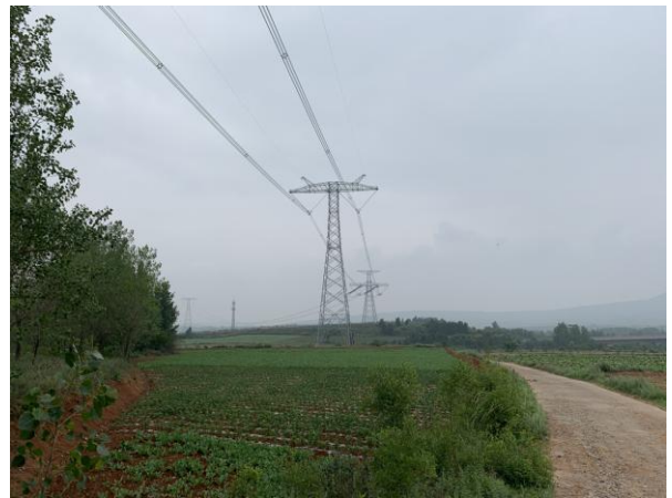
±800kV 灵绍线现状照片
