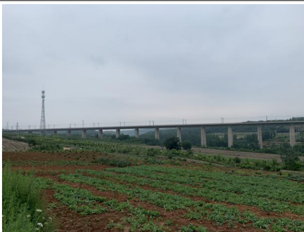
跨越郑西铁路段现状照片
