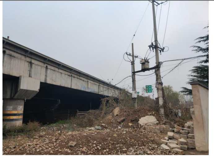
厂区南侧连霍高速
