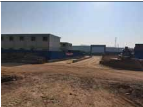
升压站站址西侧
