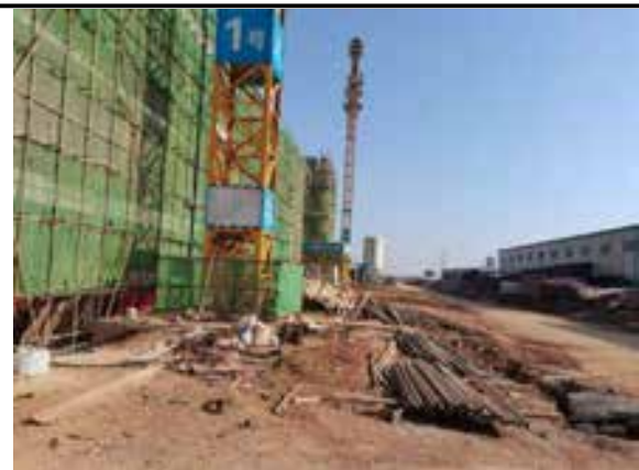
升压站站址东侧
