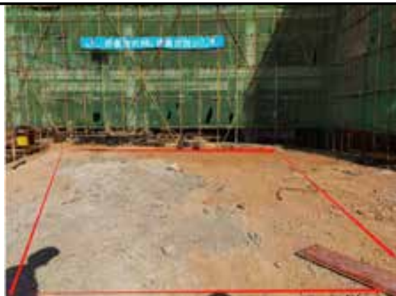
升压站站址现状
