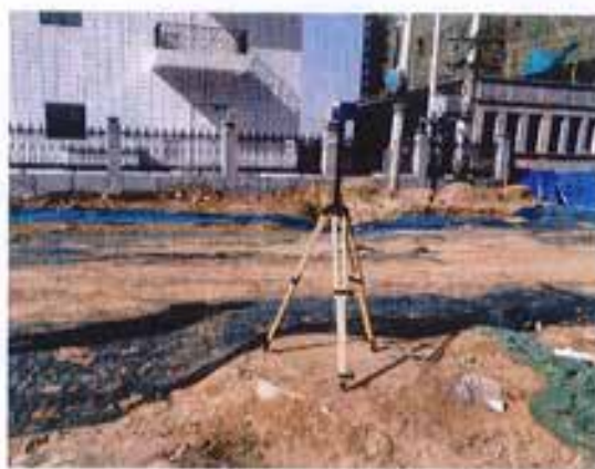
图 2 东侧电缆线路中心正上方检测照片
