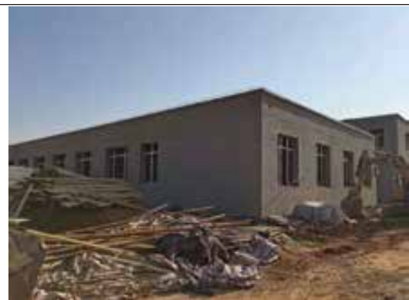
升压站站址东南侧在建 1F 办公室
