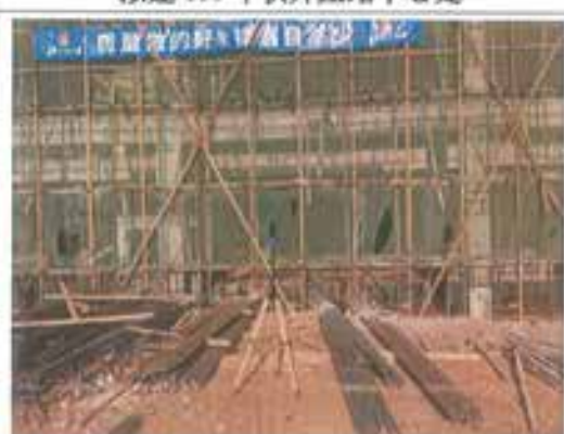
拟建 110 千伏升压站北侧
