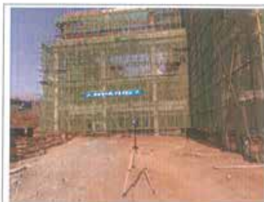
拟建 110 千伏升压站南侧
