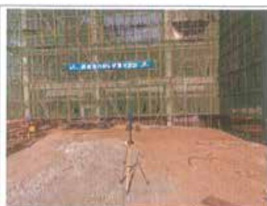
拟建 110 千伏升压站中心处
