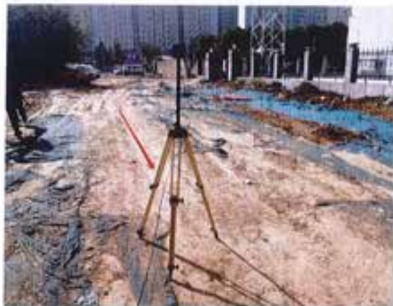
图 1 北侧断面检测照片
