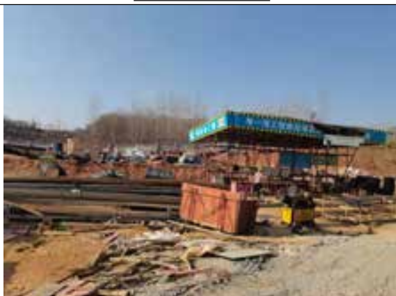
升压站站址北侧
