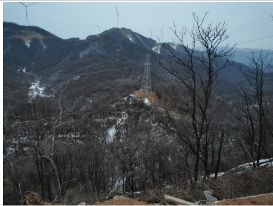
升压站站址东侧
