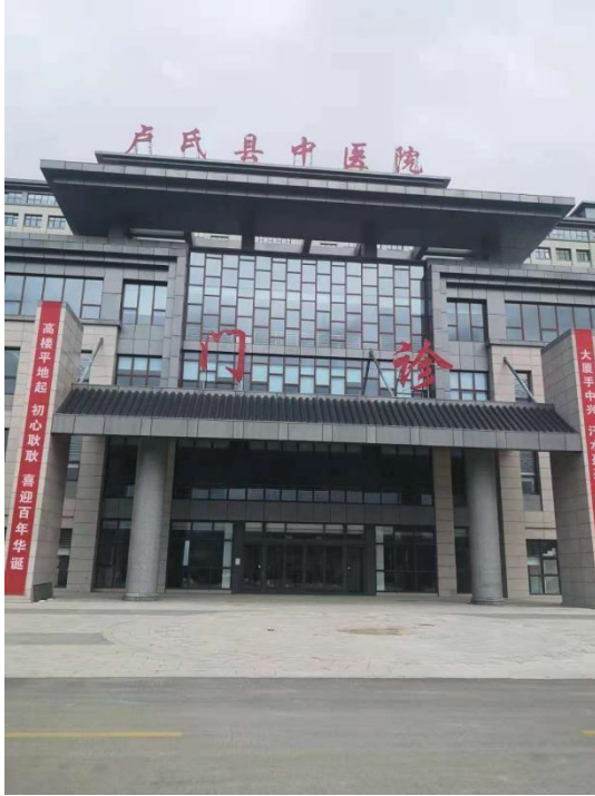
门诊医技病房综合楼西侧
