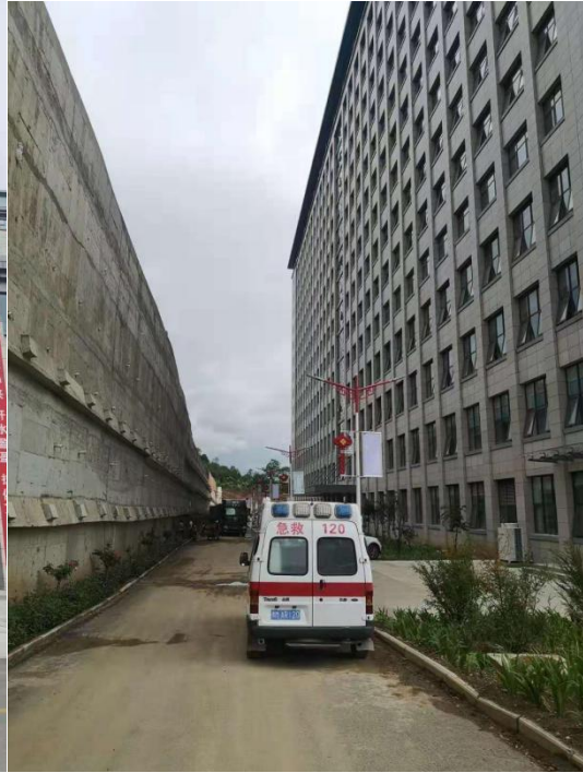
门诊医技病房综合楼东侧
