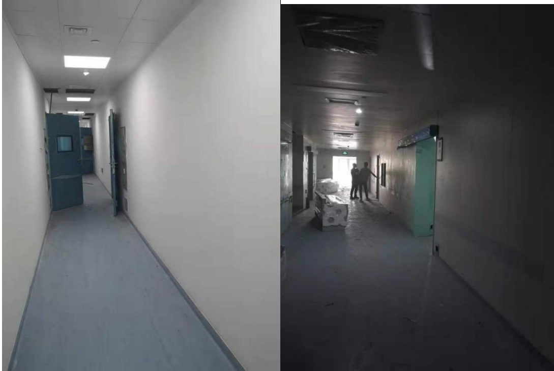
介入手术室两侧走廊现场照片
