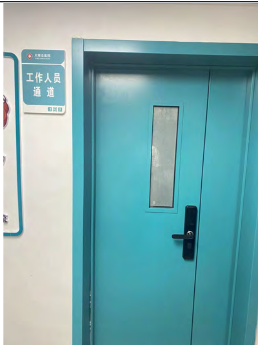
DSA 机房下方（工作人员通道）
