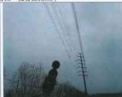
Pic1 110kV1、2 召吴线和 110kV1、2 召兴线 同塔四回输电线路噪声现状检测断面
