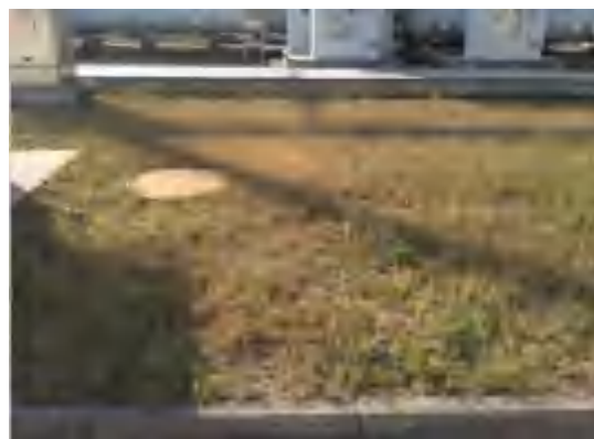
摩云变事故油池
