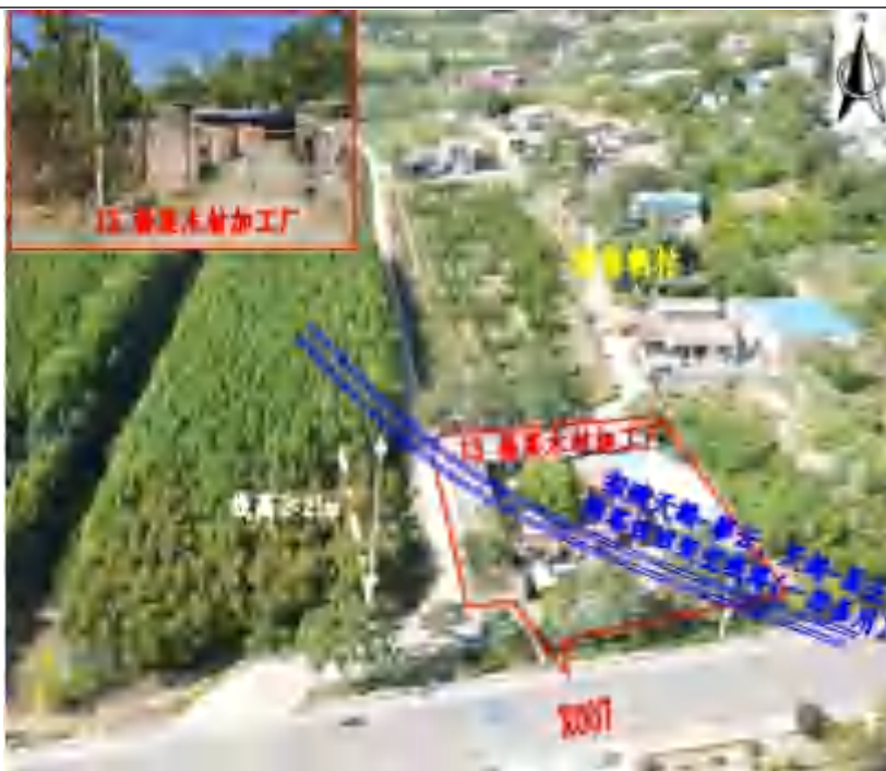
13 西南朝村线下村杨某木材加工厂，1F 坡顶砖混高约 4m，线高 \geq 16\text{m} ，净空高度 \geq 12\text{m}
