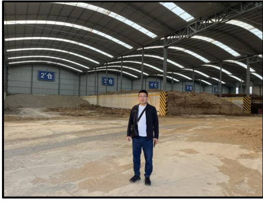
工程师看现场照片
