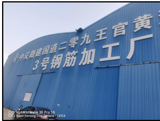
本项目东侧厂房钢筋加工厂
