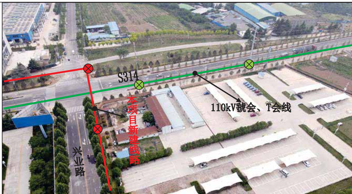
图 2-3 项目跨越电力线及等级公路位置现场照片
