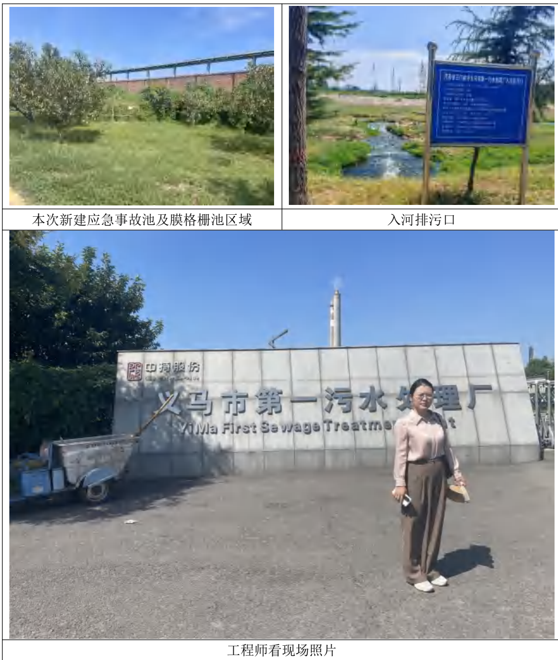
附图 22 厂区现场照片
