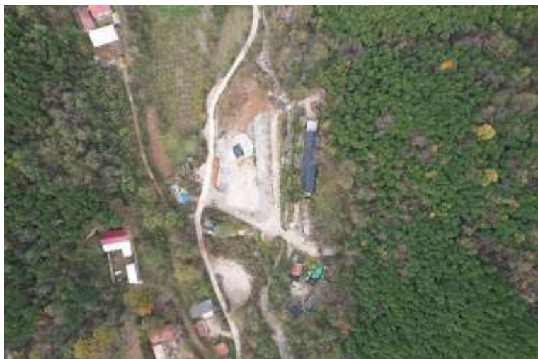
PD880 工业场地（拟拆除进行生态恢复）
