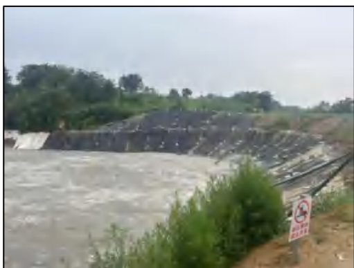
尾矿库坝内现状
