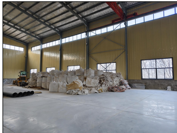
项目车间现状
