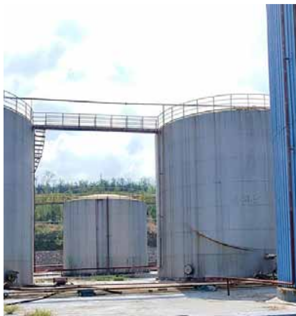
厂内现有工程罐区
