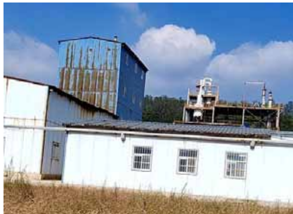
现有工程车间
