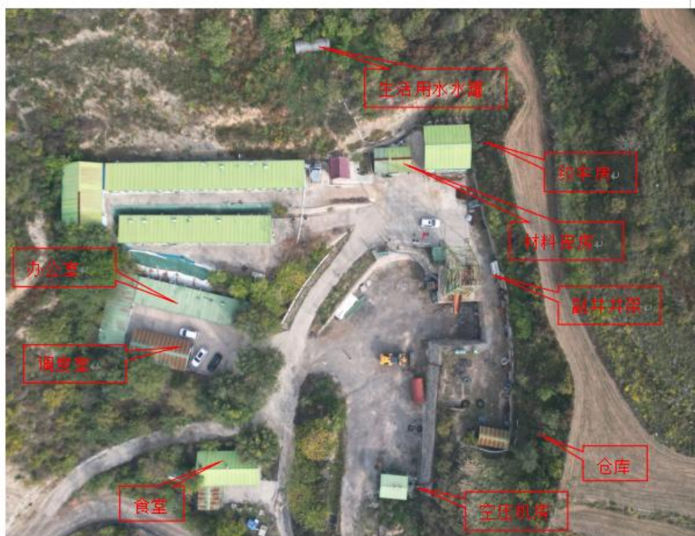
图 3.1-3 副井场地现状照片
