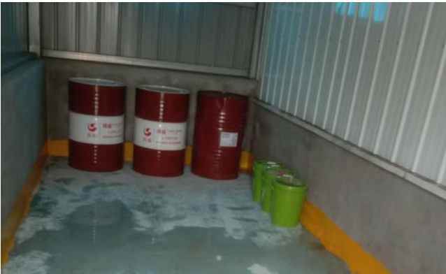
现有工程危废暂存间
