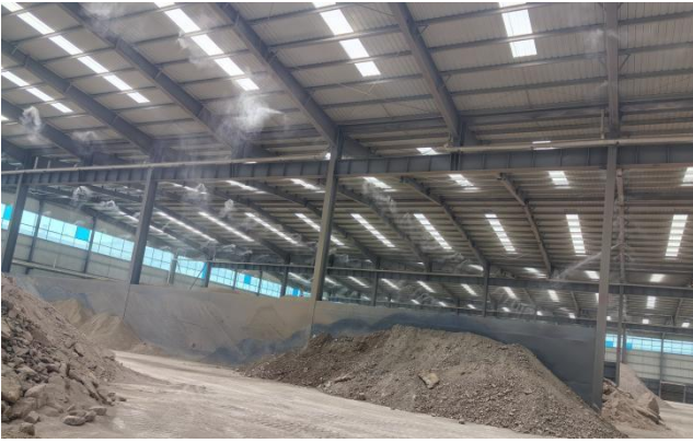
现有工程原料库
