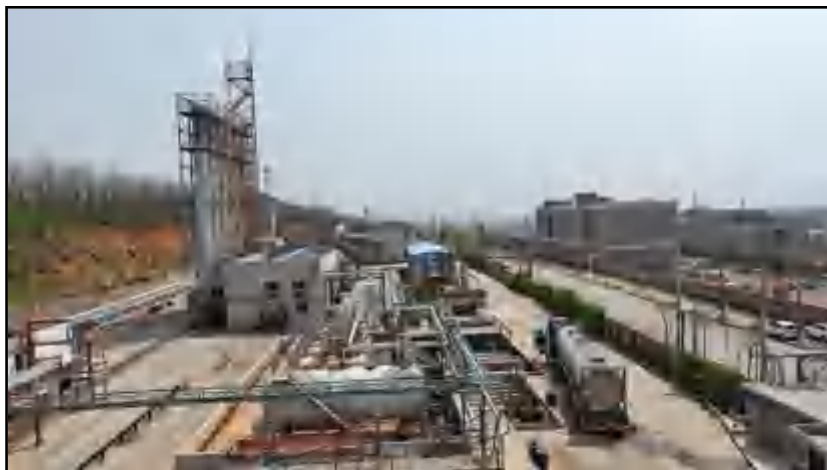
现有工程储罐区、装置区现状
