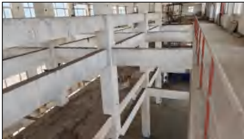
本项目拟建车间内现状
