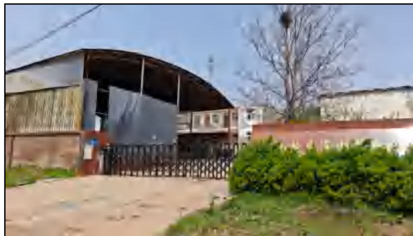
厂区外西侧河南恒庆再生资源有限公司
