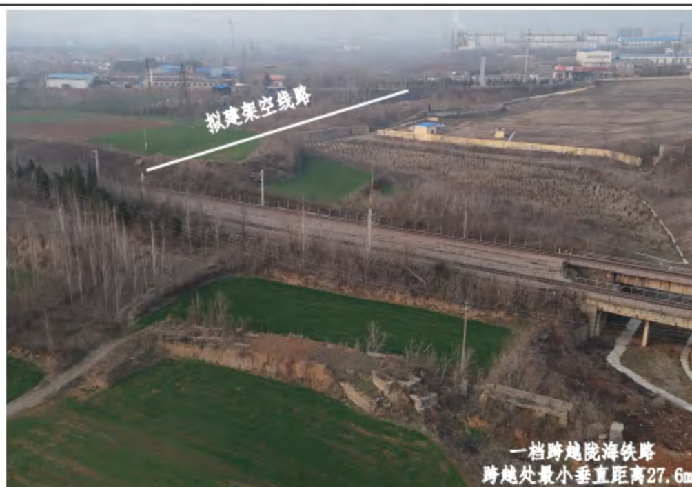
图 2-2 一档跨越陇海铁路
