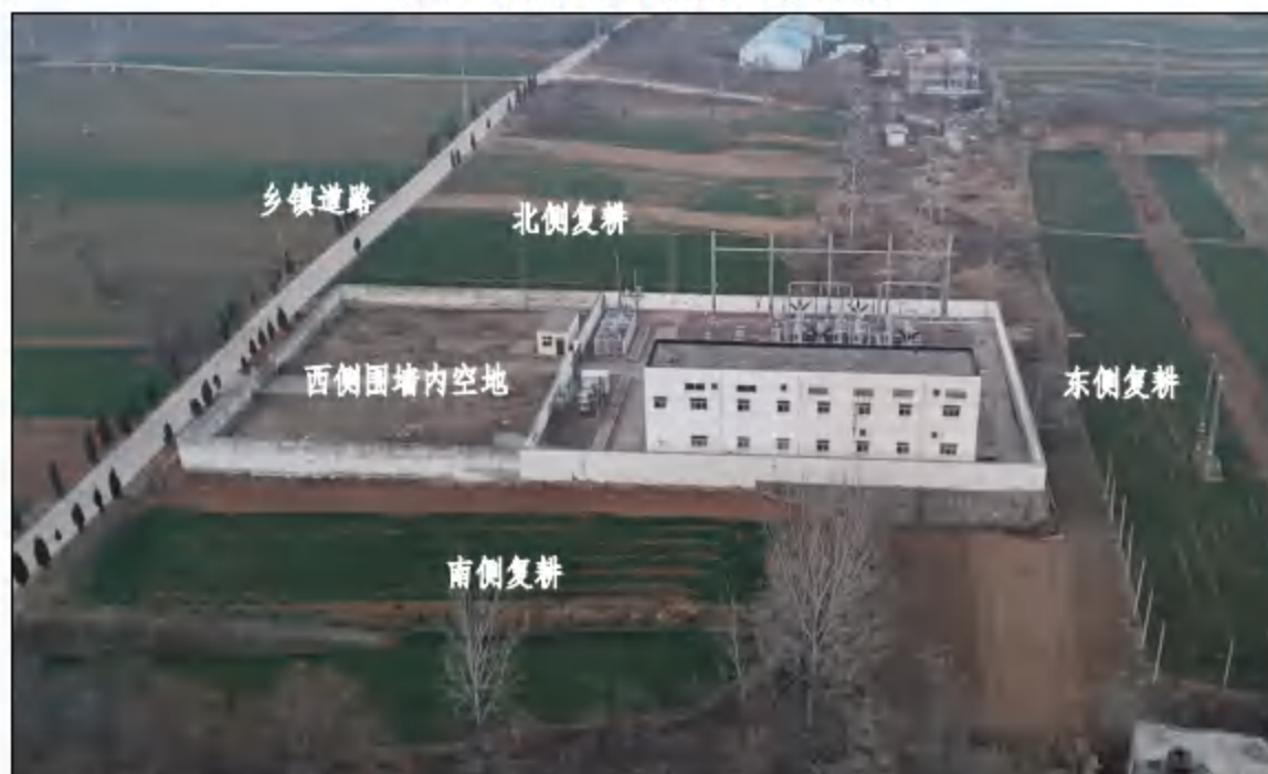
图 3-5 秦赵变电站界四周生态恢复现状照片
