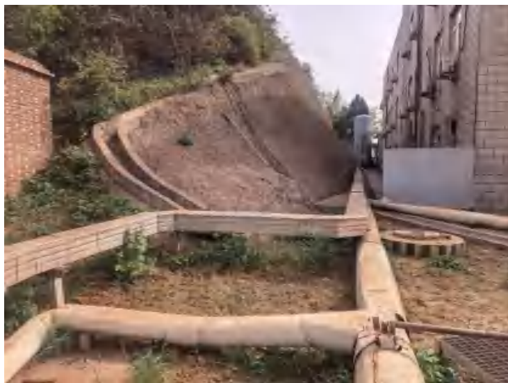
依托赤泥和回水管道
