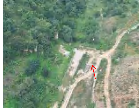
三采区斜坡道工业场地
