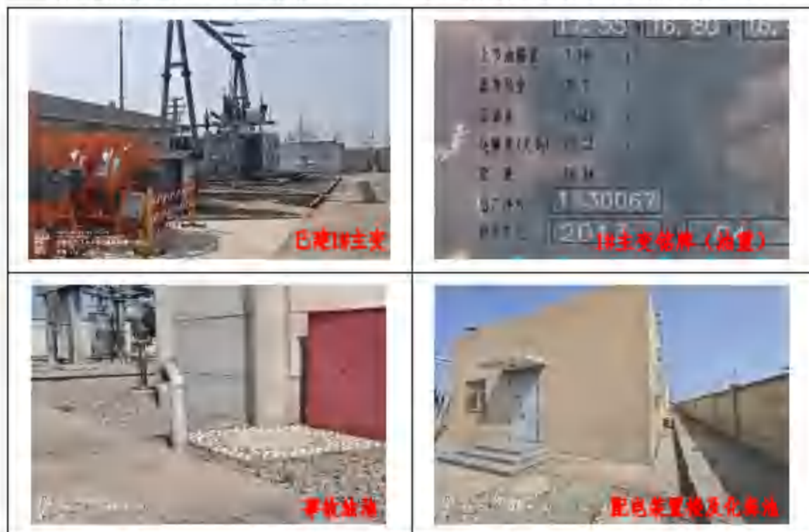
图 3-4 变电站站内现状照片
