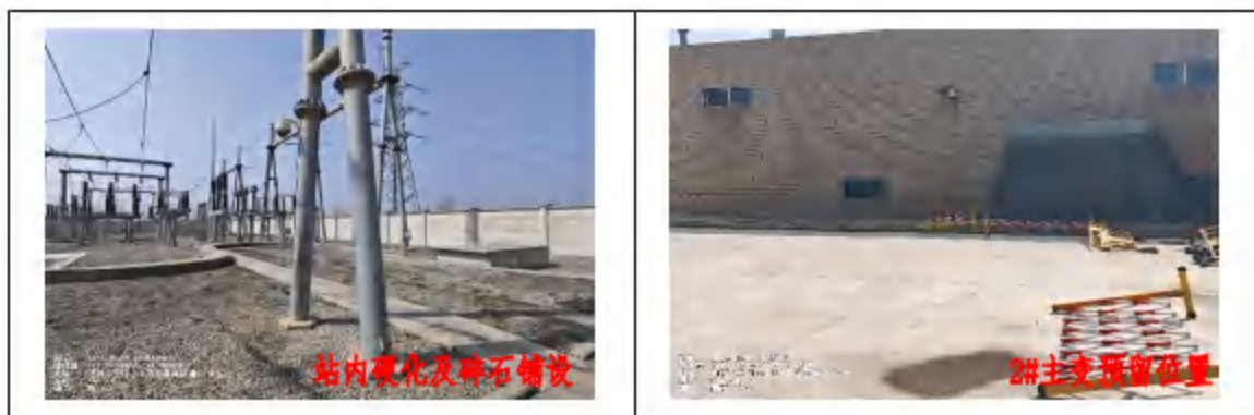
图 3-5 变电站站内现状照片
