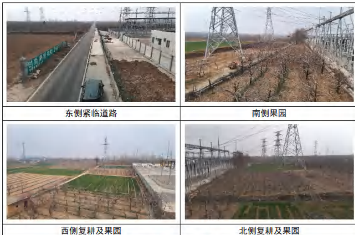
图 3-7 管营 220kV 变电站区域生态恢复现状照片
