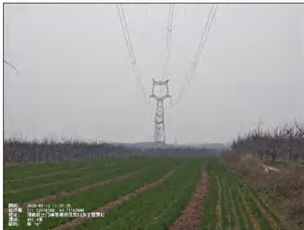
图 3-8 220kV 管高线 5#现状及塔基生态恢复照片
