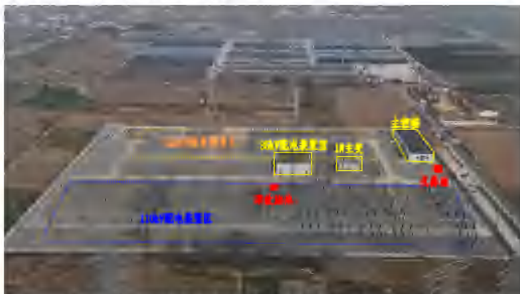
图 3-6 管营 220kV 变电站现状照片
