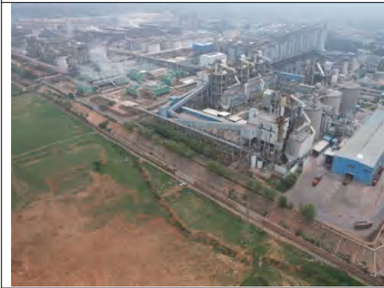
拟建 220kV 升压站站址东侧（厂区）
