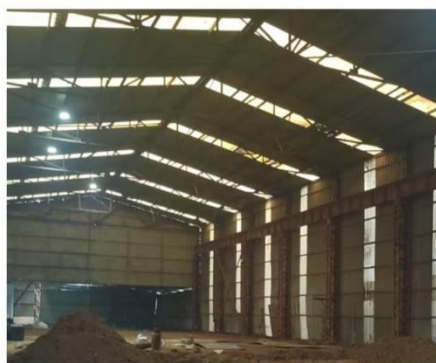
项目车间内部
